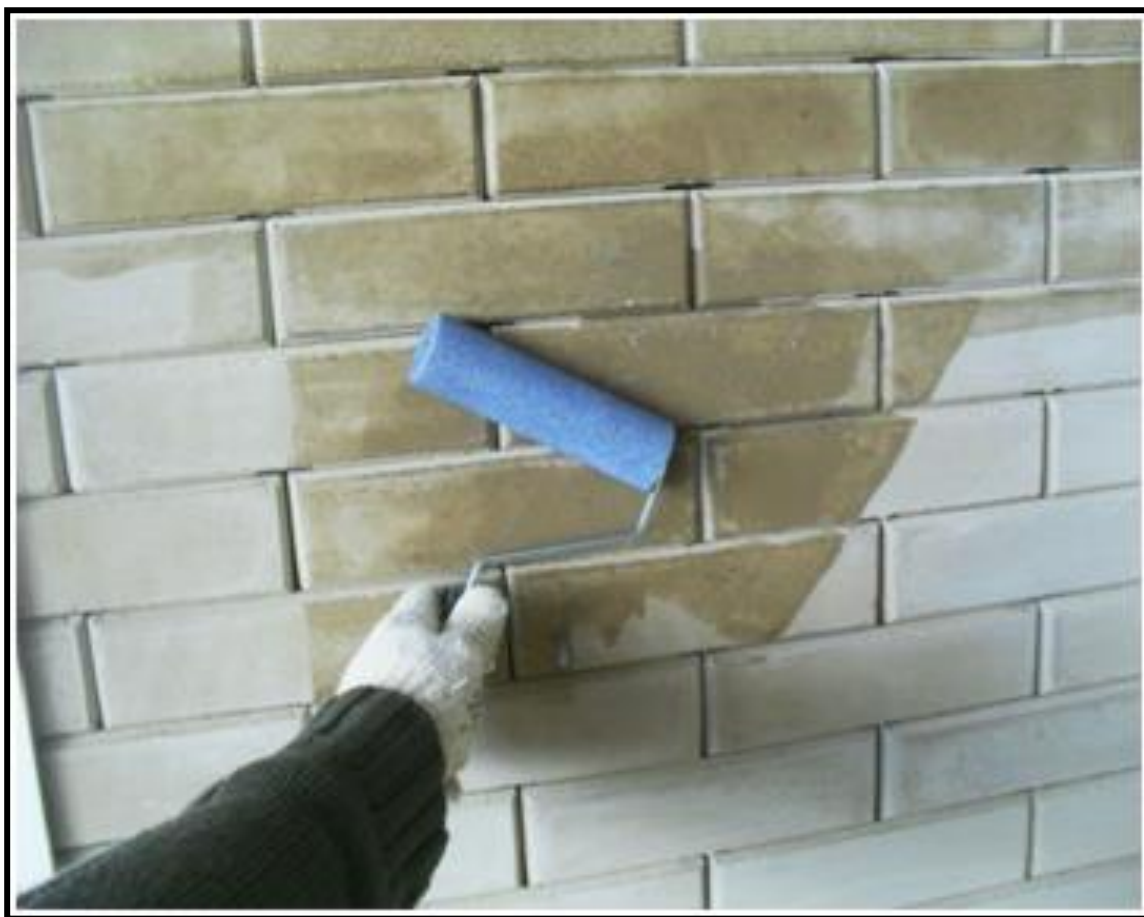
Figura 4. Aplicação de resina
