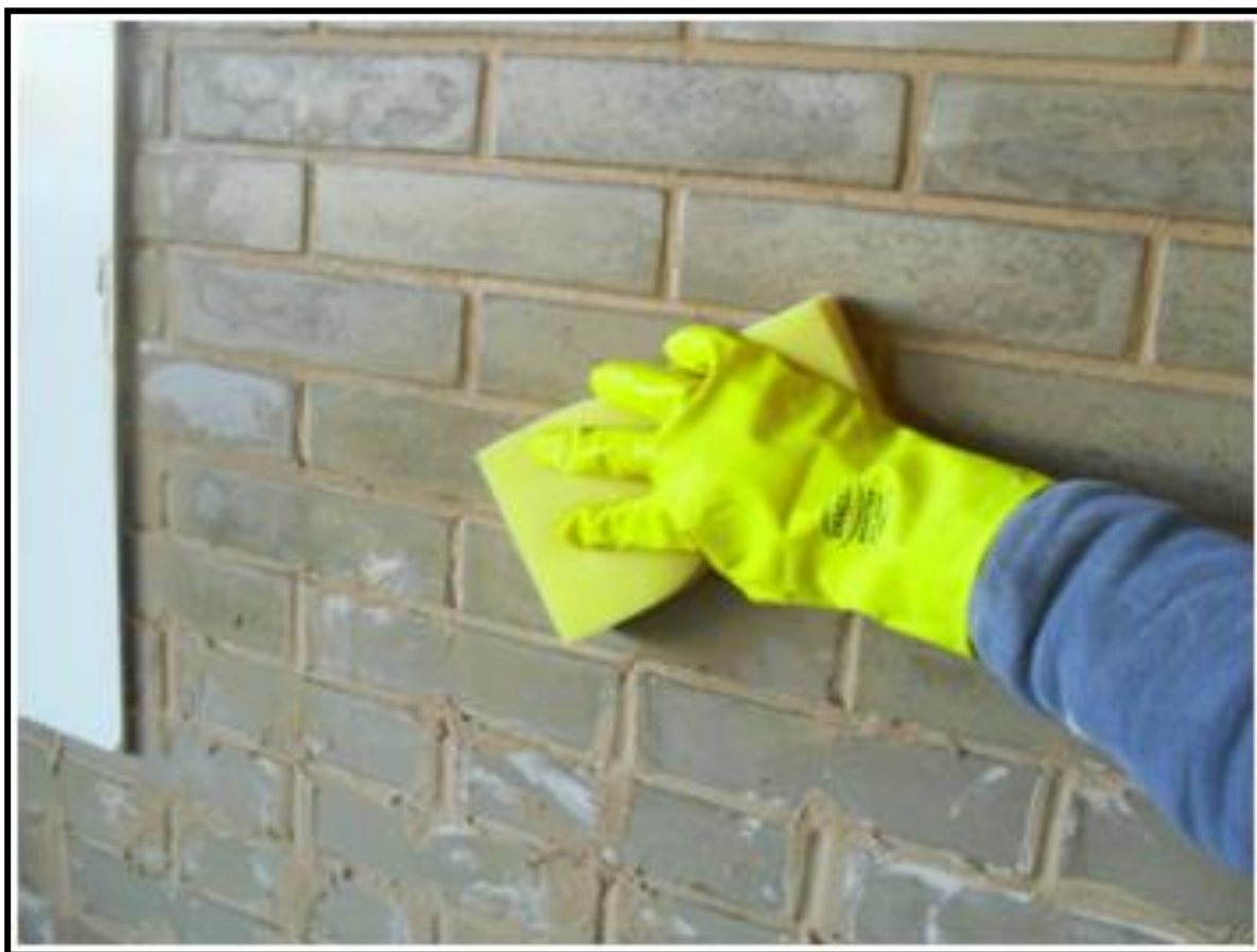
Figura 5. Aplicação de rejunte
