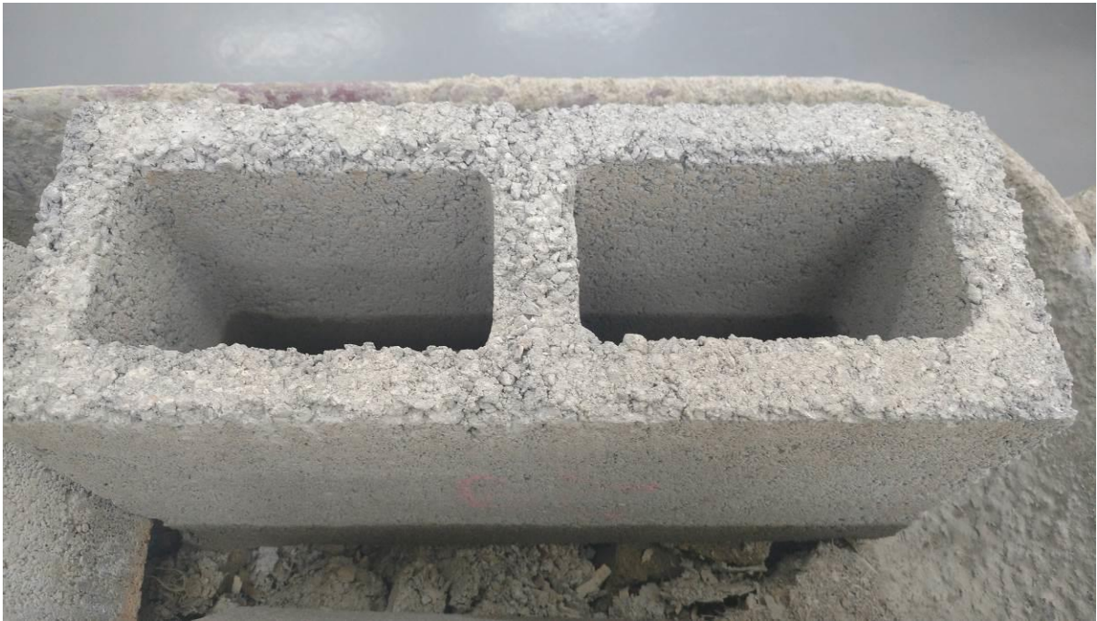
Figura 6: Fissura apresentada no traço 01 do bloco sem resíduo de madeira
