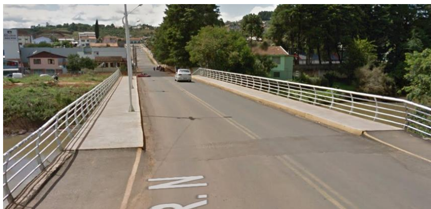
Figura 3 – Ponte do trabalhador
