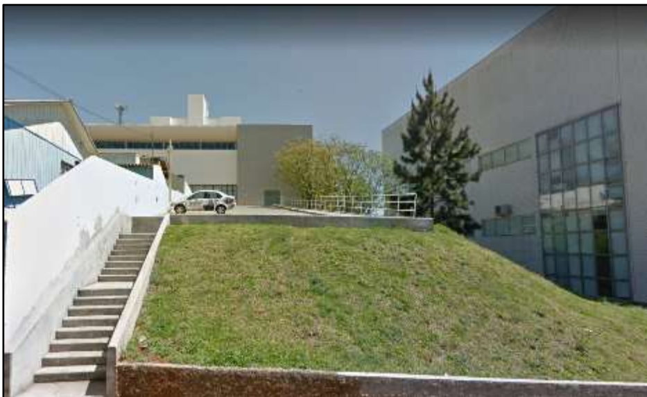
Figura 3 – 2ª Parte do Frontal do Terreno
