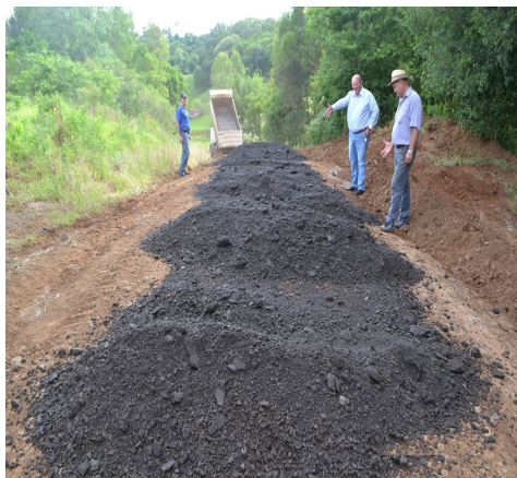
Figura 2: Material fresado sendo espalhado pela caçamba em Videira
