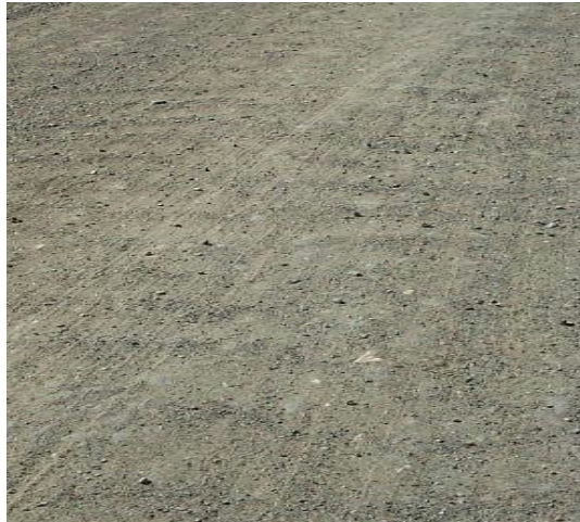
Figura 7: Via Primária com o Material Fresado em Joinville
