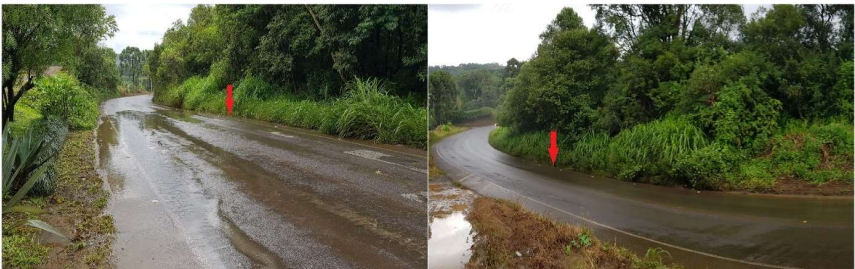
Figura 5: Início e Fim do Aumento de Capacidade da Sarjeta de Corte
