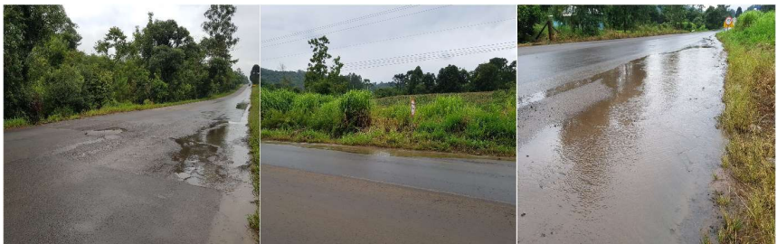
Figura 2: Acúmulo de Água / Ampliação de Valeta e Implantação de Sarjeta
