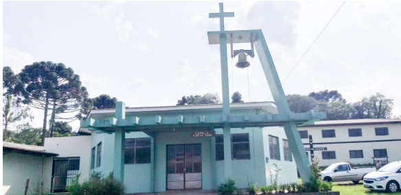
Figura 11: Fachada Capela Nossa Senhora da Saúde
