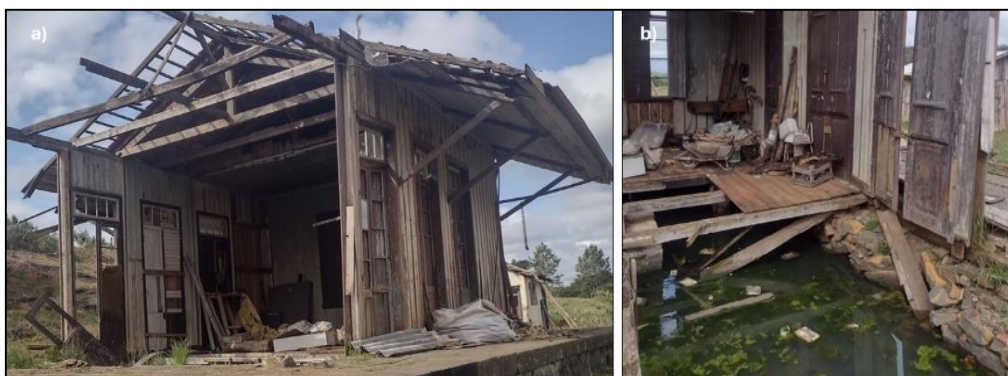
Figura 4 – Fachada frontal (a) e Interior da Edificação (b).
