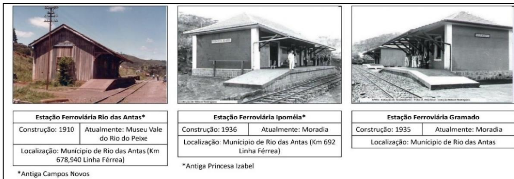
Figura 3 - Estações Ferroviárias Comarca de Rio das Antas.
