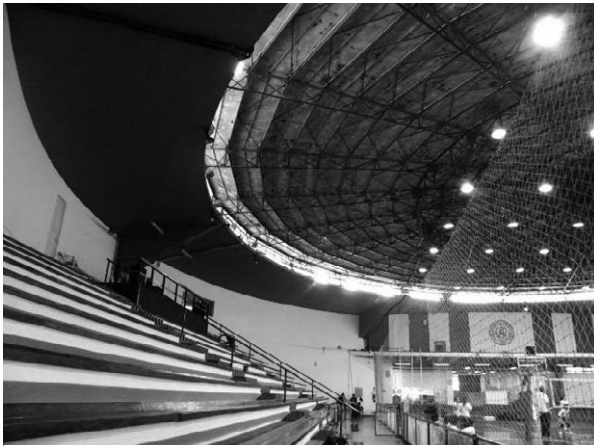
Figura 3 – Arquibancadas de acesso
