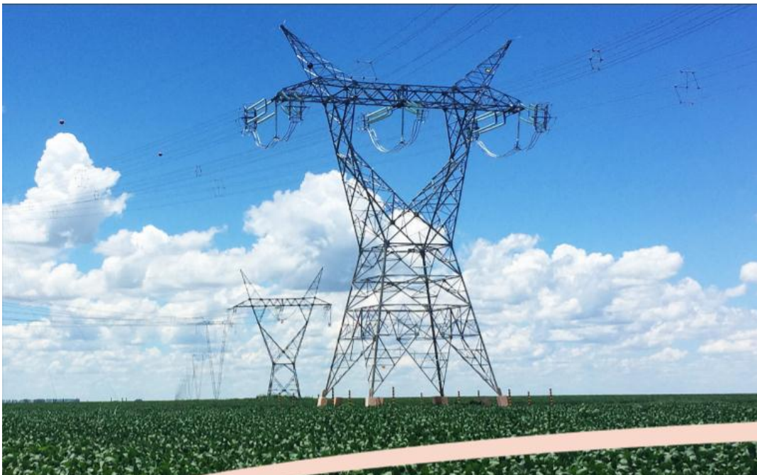
Fig 8 – Torres de Transmissão Fonte: Agencia Sertão
