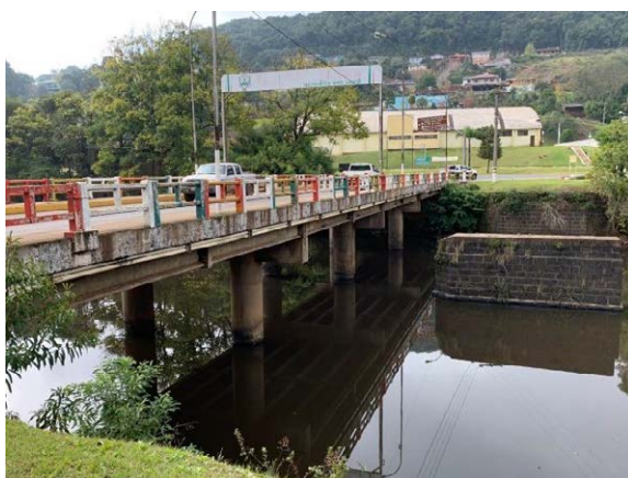
Figura 2 – Vista lateral direita da ponte Avelino Antonio Sella
