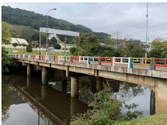
Figura 1 – Vista lateral esquerda da ponte Avelino Antonio Sella
