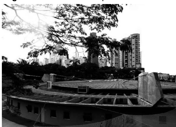
Figura 8: Entradas de luz pela cobertura
