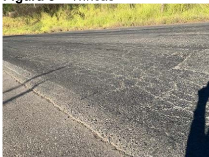
Figura 5 – Trincas
