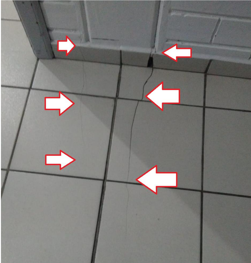
Figura 16 – Encontro da placa cerâmica com a coluna
