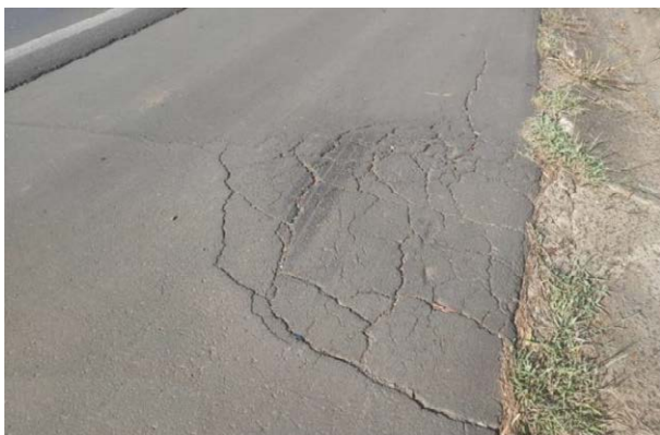
Figura 03 – Trincas JE/FC-3
