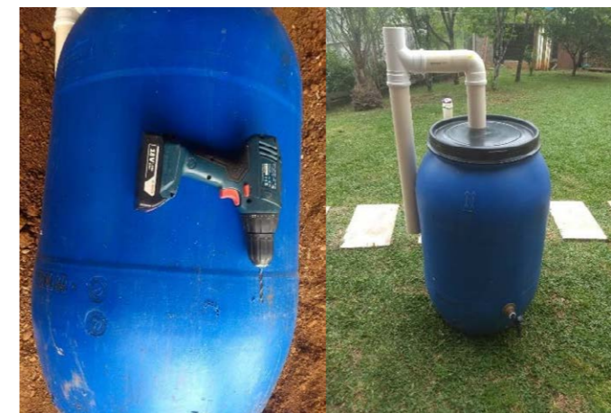
Figura 2 – Furação Tambor, para colocar torneira, para saída da água. Cisterna pronta.
