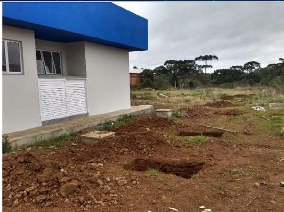
**Figura 1** – Escavações para ser feita a fundação
