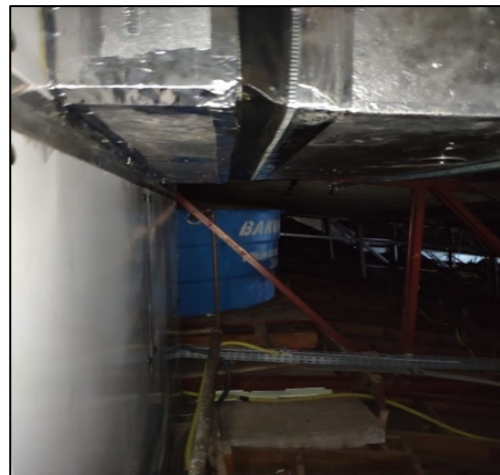
Figura 2 – Estrutura de apoio dos reservatórios
