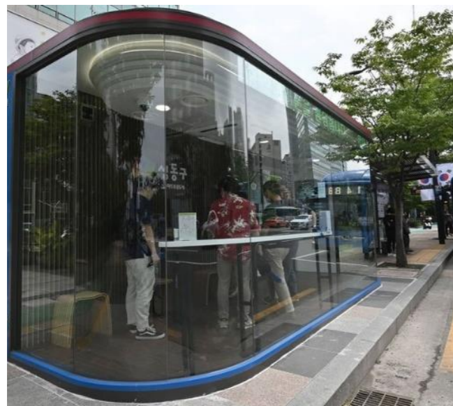
Figura 1 – Vista de ponto de ônibus na Coreia do Sul
