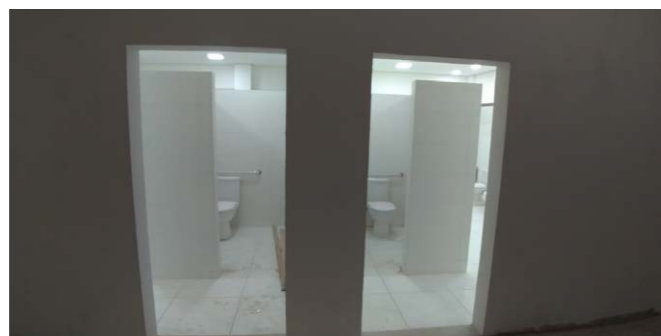
Imagem 1 – Banheiros 2º pavimento.
