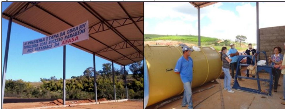
Figura 2: Conclusão da obra do galpão e instalação das máquinas.
